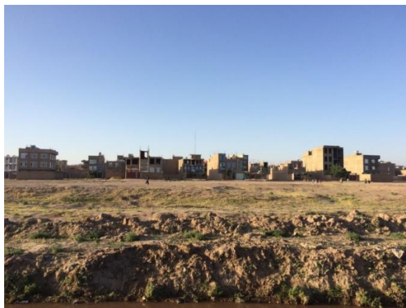
شکل (۱): ساخت‌وساز در اراضی زراعتی شهر هرات
